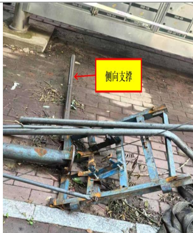
鸡公吊底座侧向支撑
