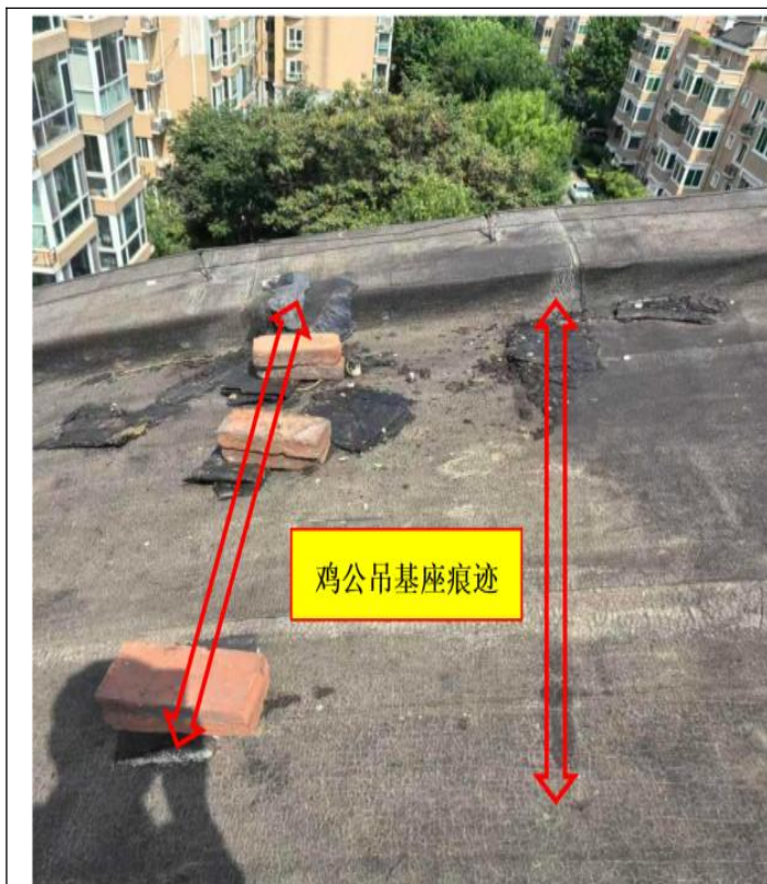
屋面鸡公吊作业痕迹
