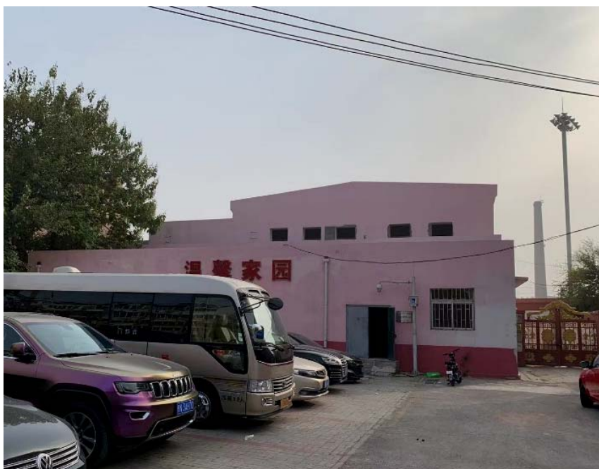
锅炉房北立面现状
