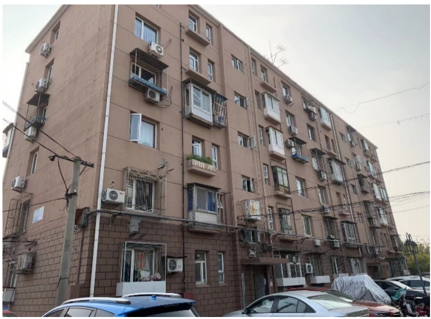
锅炉房西侧现状
