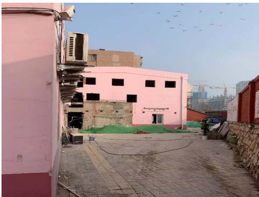
锅炉房南立面现状
